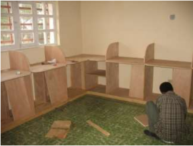
Les travaux sont réalisés par des artisans locaux
