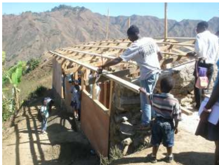
Construction en cours
