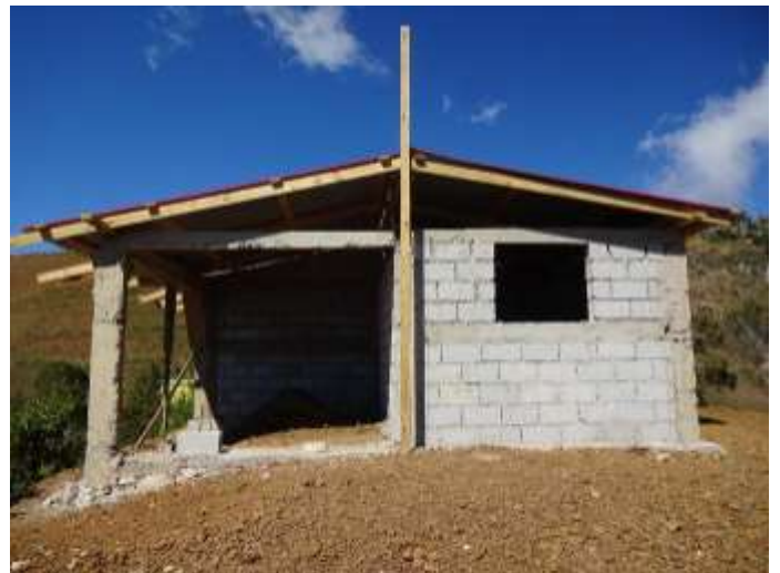
Visite du chantier le 06 janvier 2017
