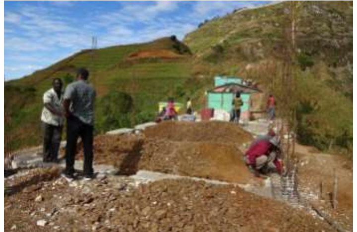
Visite du chantier le 10 décembre 2016
