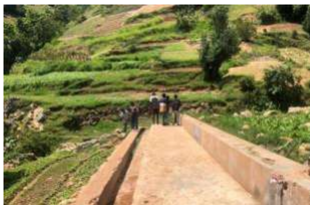
Réhabilitation d'un lavoire dans la localité de Desmoulins
